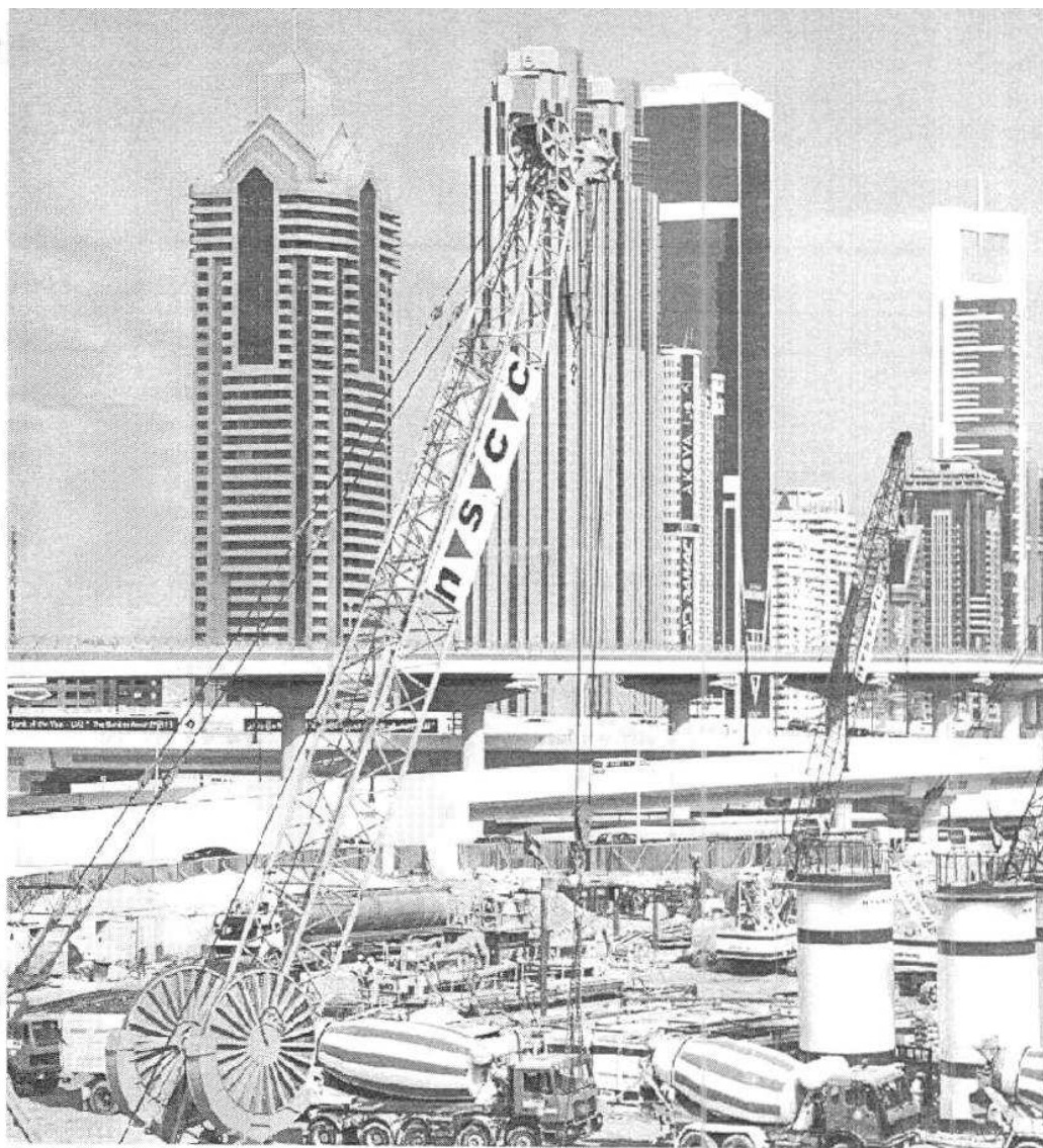
Cantieri aperti. Ruspe e camion al lavoro sulla Sheikh Zayed road
